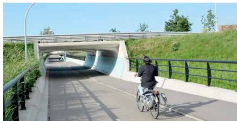
Schnelle, gefahrenfreie Unterquerung der Semmelweisbrücke
